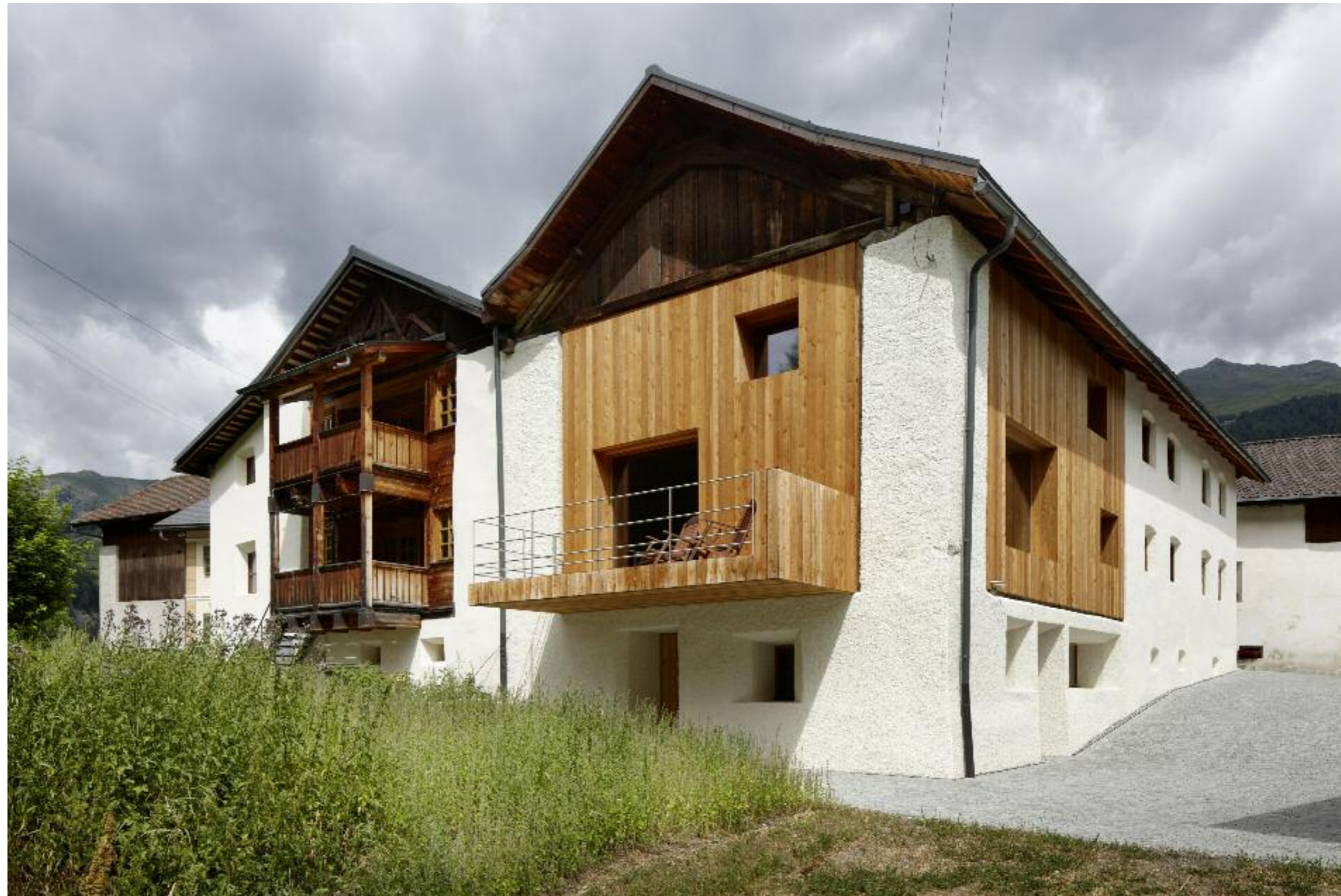
Zwischen den gemauerten Eckpfeilern der ehemaligen Scheune „schiebt“ sich der eingestellte Holzbau nach außen und endet bündig mit der Bestandsfassade.
